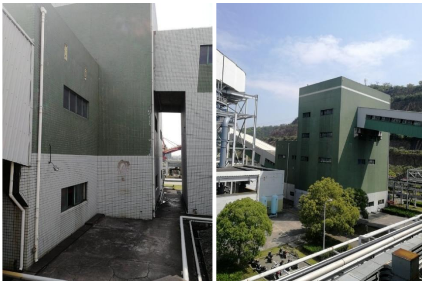
图 6.2-3 封闭式结构转运站示例照片
