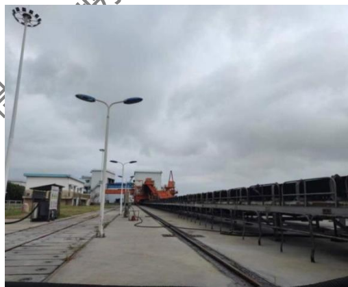
港池东侧码头平台皮带机
